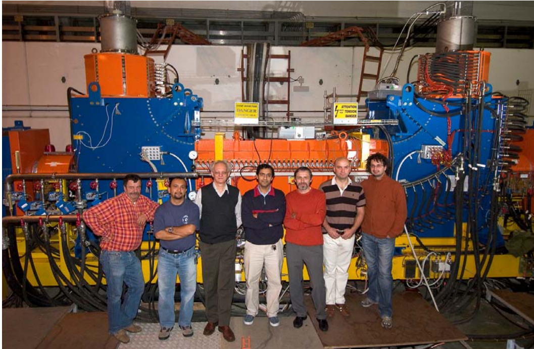
Рисунок 5 Установка электронного охлаждения после успешной проверки в накопительном кольце LEIR.
